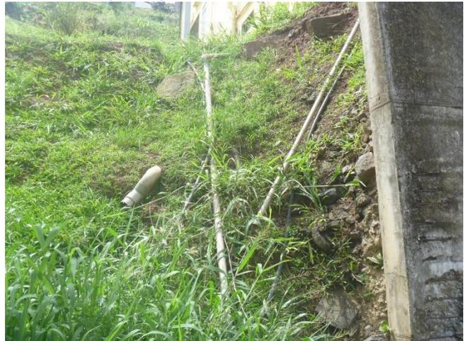
Figure 3.11 - Raccord eaux usées et caniveau
