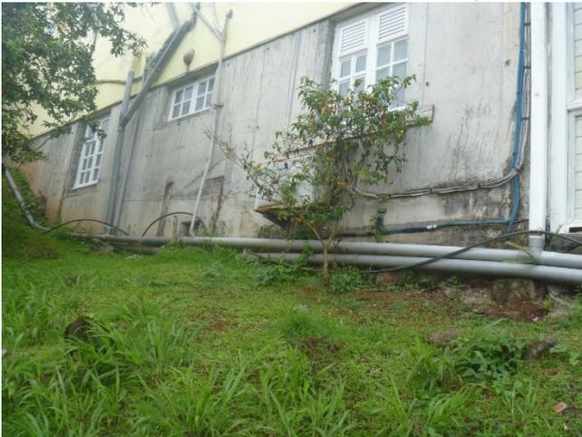
Figure 3.10 - Raccord eaux usées et eaux pluviales
