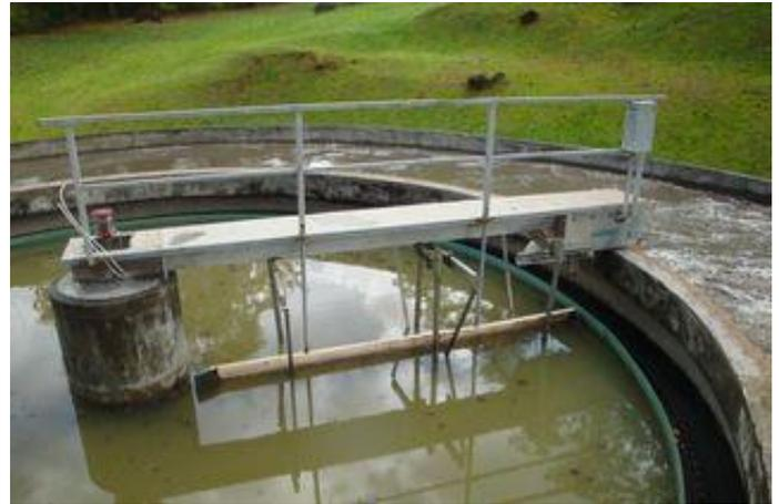
Figure 2.4 – Clarificateur et pont racleur
